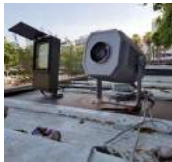
▲ Proyector de haz elíptico con visera superior y proyector de imágenes, antes de ajustar las orientaciones.
